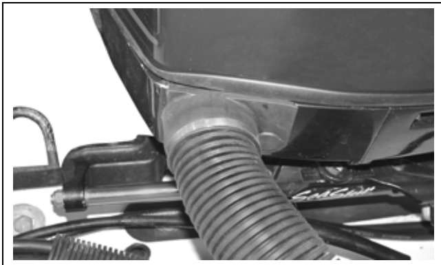
Flexible conduit installation
