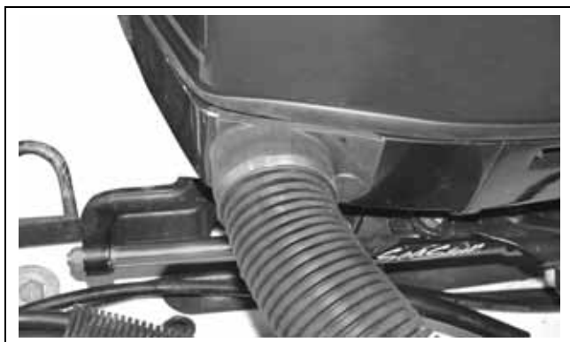
Flexible conduit installation
