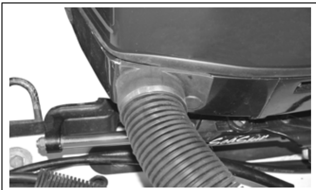
Flexible conduit installation
